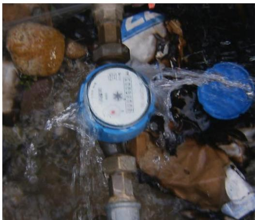
Due o tre giornate con temperature al di sotto dello zero sono sufficienti perché l'acqua possa gelare, provocando la rottura degli apparecchi. I contatori maggiormente "a rischio" sono quelli collocati all'esterno dei fabbricati, in locali non isolati o in abitazioni utilizzate raramente.
