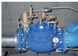
valvola di controllo della pressione
