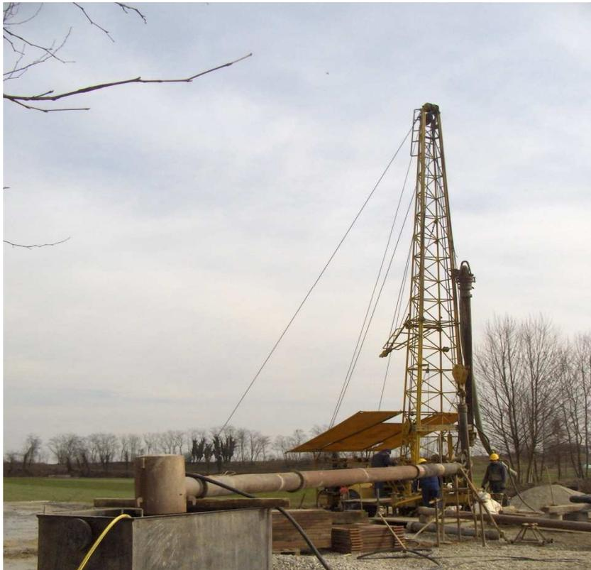
Attraverso un processo di **“terebrazione”** viene sondato il sottosuolo alla **ricerca della risorsa idrica**.
